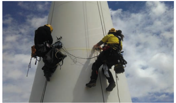
Inspección de las soldaduras de una torre de aerogeneradores.
